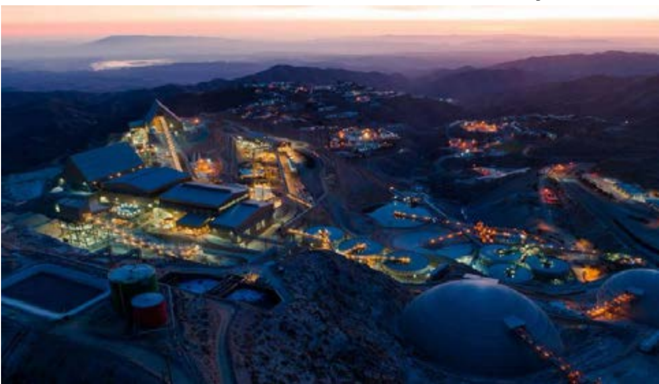
Ampliación Concentradora Toquepala, Perú. Foto: Cortesía Grupo México
